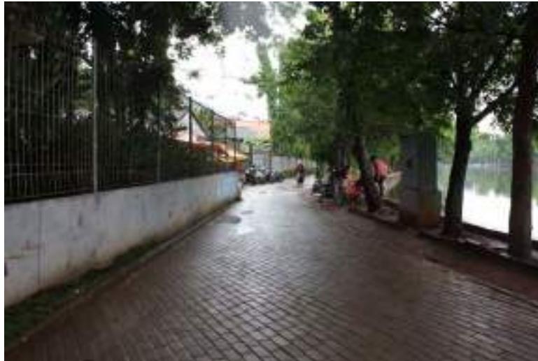
Gambar 4.4.1.39 Penyempitan jalan (Sumber : dokumentasi pribadi Februari 2016)
