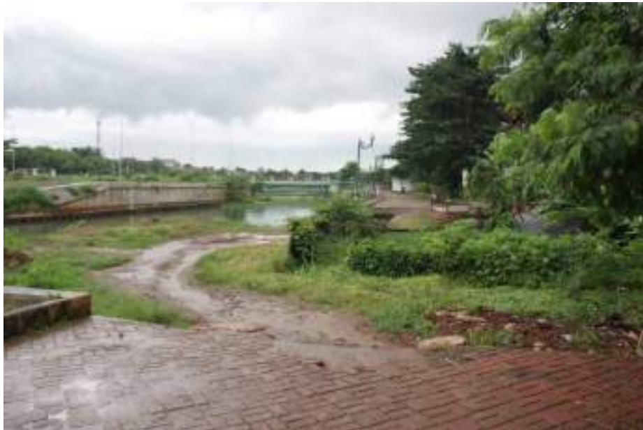
Gambar 4.4.1.32 Jalan terpotong (Sumber : dokumentasi pribadi Juli 2016)
