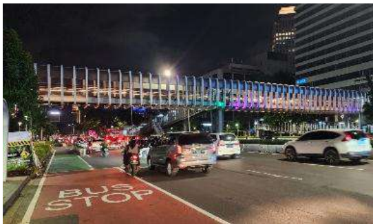
Gambar 7. Fasilitas Tranportasi Eksisting Sumber: Data Pribadi
