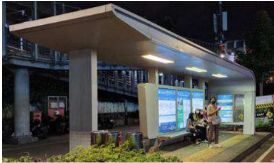
Gambar 8. Fasilitas Tranportasi Eksisting Sumber: Data Pribadi
