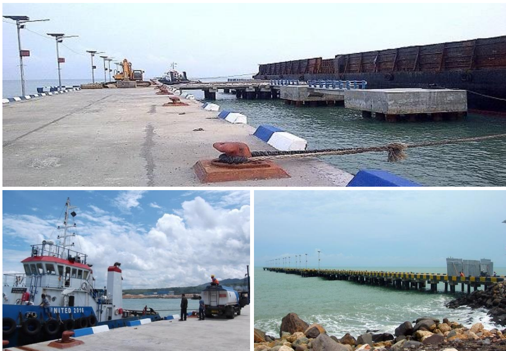
Gambar 4-31 Kondisi Pelabuhan Rembang di Kecamatan Sluke
