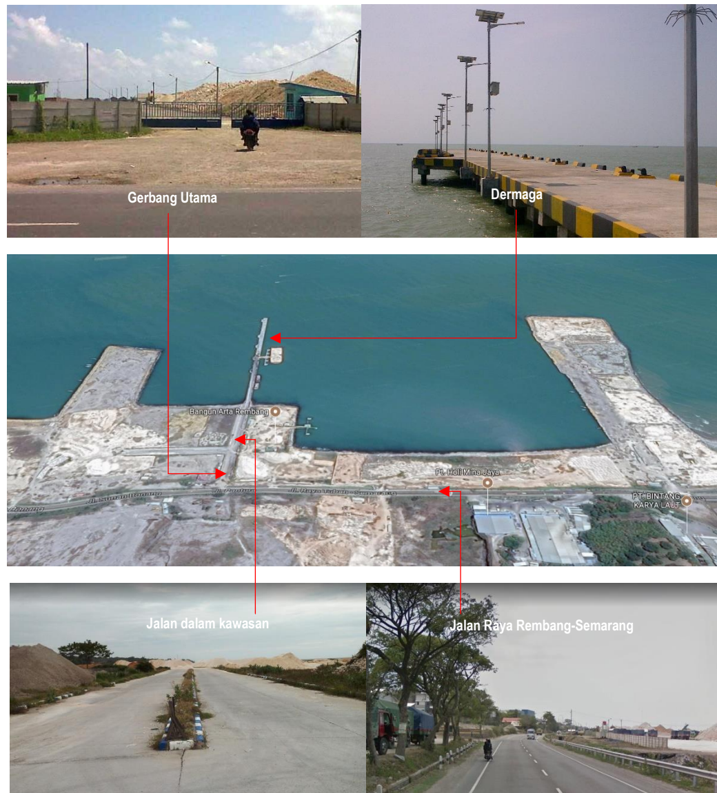
Gambar 4-33 Kondisi Eksisting Sarana Prasarana di Pelabuhan Rembang Sluke
