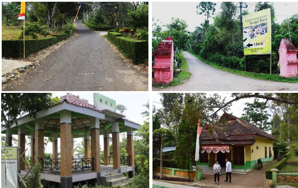
Gambar 4-16 Kondisi Sarana Prasarana Kawasan Wisata Panglungan
