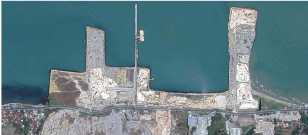
Gambar 4-36 Kondisi Lahan Eksisting Pelabuhan Umum Rembang
