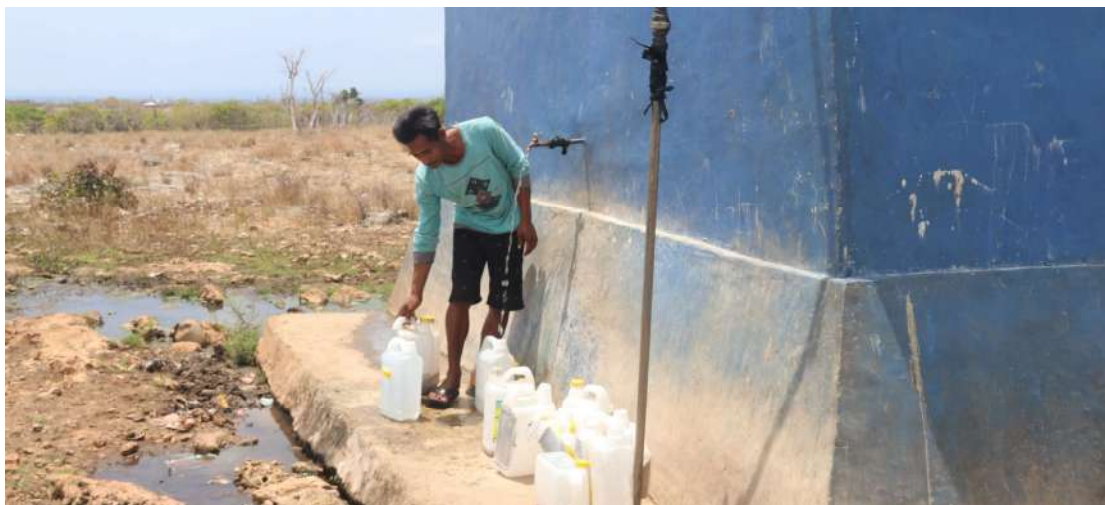
Gambar 4.1 Bak penampungan air
