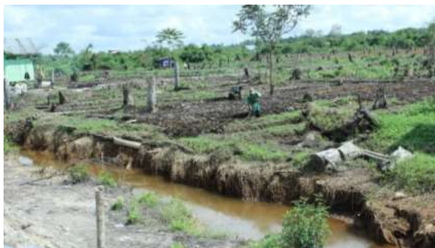
Gambar 6.24 Saluran Irigasi di Lokasi SP6B
