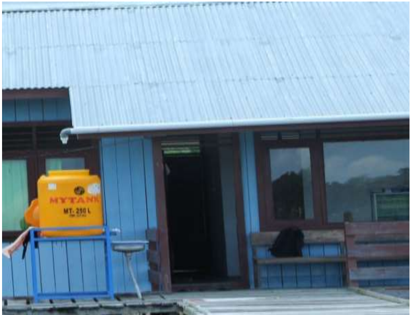
Gambar 7.4 Tanki Penampung Air Hujan
