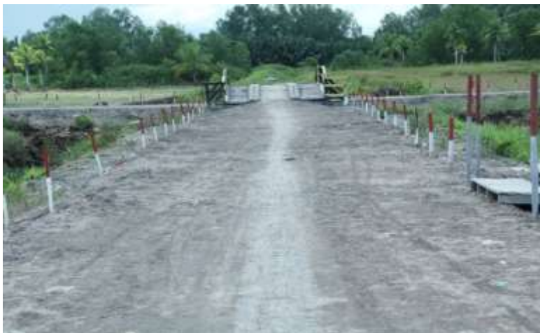
Gambar 7.20 Jalan Lingkungan di Lokasi Transmigrasi SP10, TanjungBuka
