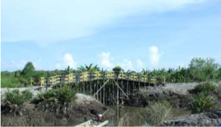
Gambar 8.12 Jembatan di Lokasi Sepunggur
