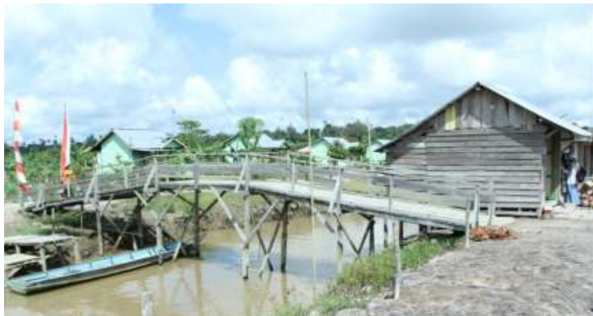
Gambar 6.23 Jembatan di Lokasi SP6B
