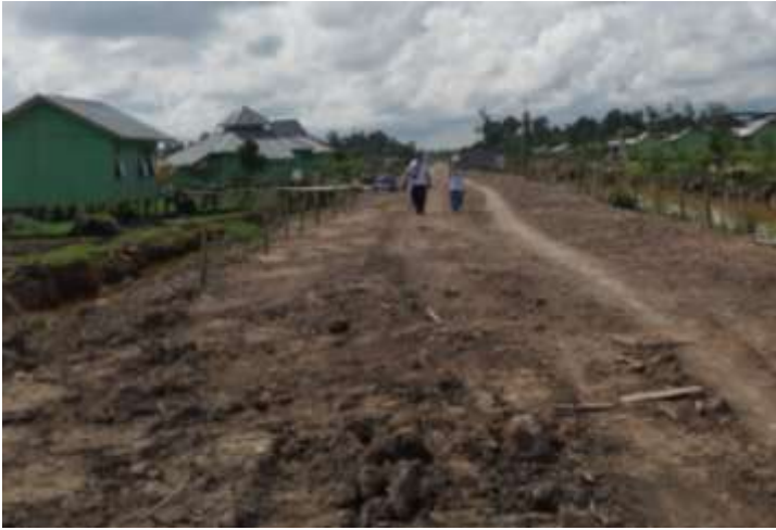
Gambar 6.4 Kondisi jalan poros di SP6B
